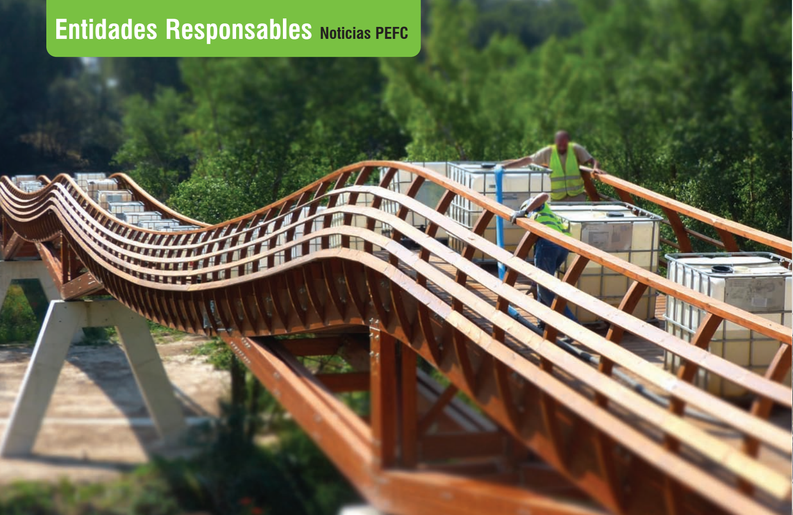
▲ Puente Senda Duero entre Bocos y Olivares. Valladolid
